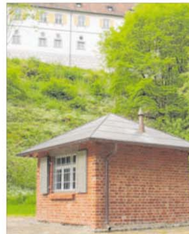
Das Brunnenhaus mit Pumpe von 1906 hat der Förderverein Schloss Filseck zu neuem Leben erweckt. Foto: Förderverein
